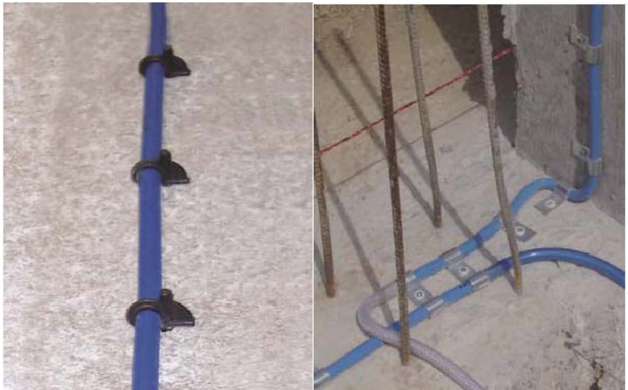
Рисунок 6 – Крепление инъекционного шланга
